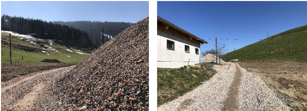
Abbildung 10: Beispiel von lose eingesetzten Mischabbruchgranulaten (vermutlich ohne Abscheidung der Fraktion <8mm) nach dem Rückbau eines alten Stalls auf einem Bauernhof.
