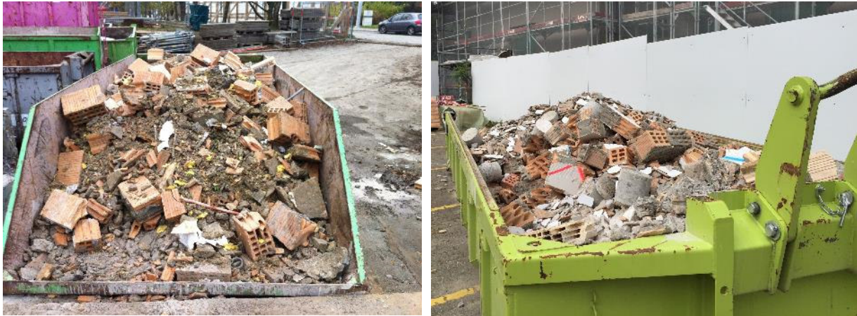
Abbildung 3: Fotos von Mischabbruchmulden aus Sanierungsprojekten in der Stadt Zürich, welche im Rahmen von Controllingprojekten von Rückbau- und Entsorgung bei Grossprojekten durchgeführt werden.
