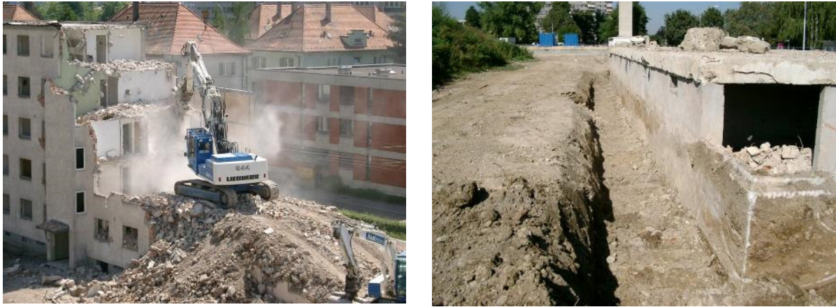
Abbildung 2: Rückbau der Wohnsiedlung Werdwies in Zürich-Altstetten. Zunächst werden die oberirdischen Gebäudeteile ohne Materialtrennung zurückgebaut (Bild links), wobei der Mischabbruch entsteht. Danach erfolgt der Rückbau der Kellergeschosse (Bild rechts), wobei der Betonabbruch entsteht.
