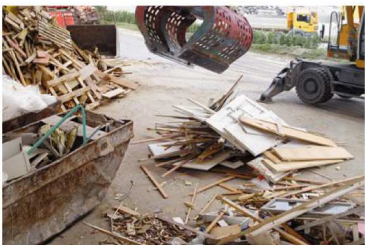
Déchets de chantier tout-venant et bois usagé
