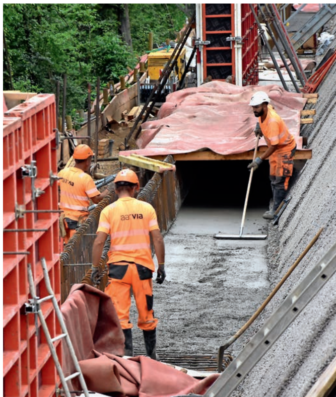
3 | Einbau des Fundamentbetons (Foto: arv Baustoffrecycling Schweiz). 3 | Mise en place du béton de fondation (photo: asr Recyclage matériaux construction Suisse).
