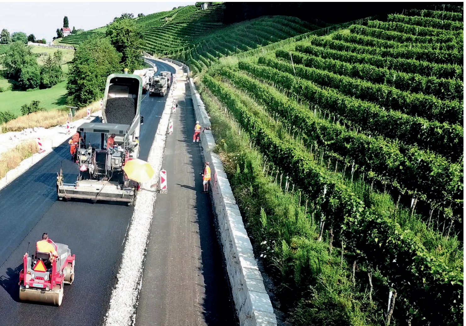
1 | Einbau des Belages mit hohen Recyclinganteilen im Strassenabschnitt Würenlos-Oetwil (Foto: arv Baustoffrecycling Schweiz).
