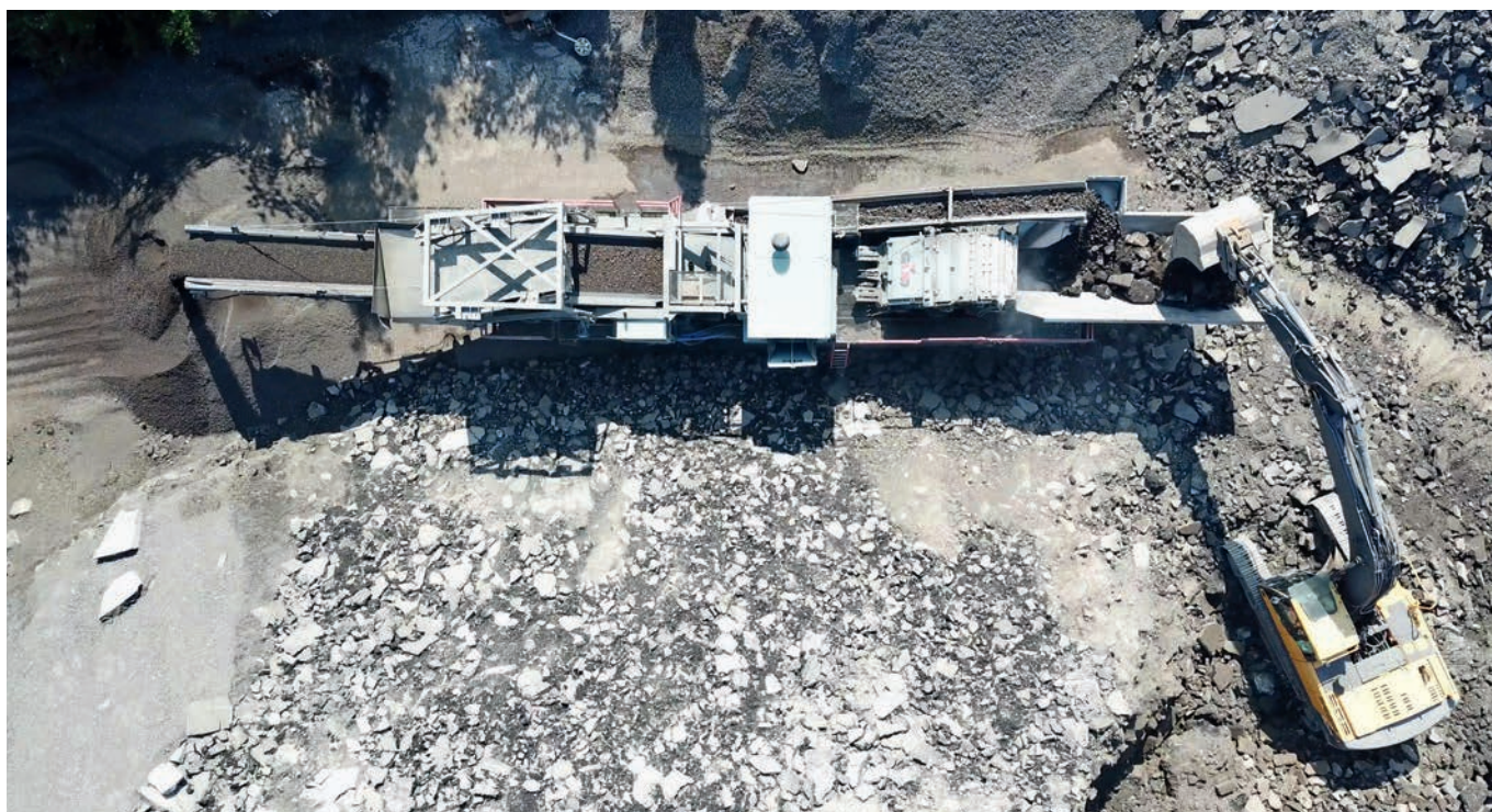
2 | Aufbereitung von Belagsmaterial (Belagsgranulat) im Werk (Foto: arv Baustoffrecycling Schweiz).
