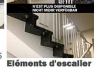
Eléments d'escalier en belle pierre artificielle Démontage: semaine/année 39/2016
