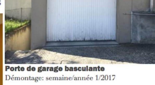
Porte de garage basculante Démontage: semaine/année 1/2017
