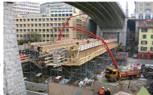
Construction d'un ouvrage en béton
