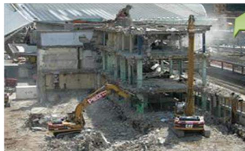
Démolition d'un bâtiment.
