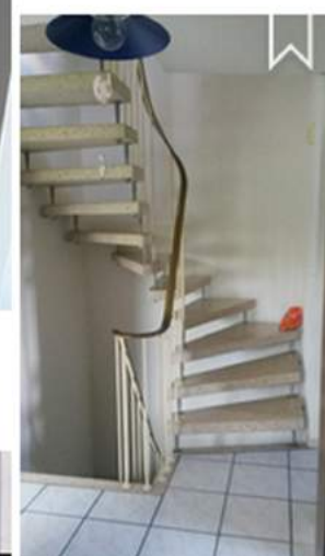
Treppe Démontage: semaine/année 29/2016
