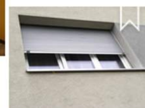
Tablier de volets roulants Démontage: semaine/année 6/2017
