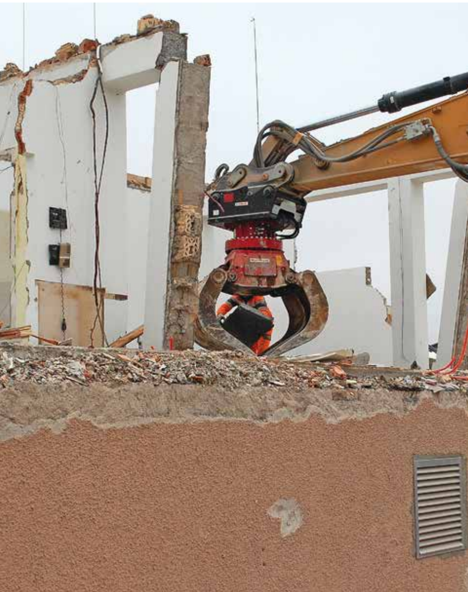
Betonabbruch ist ein wichtiger mineralischer Rückbaustoff.
