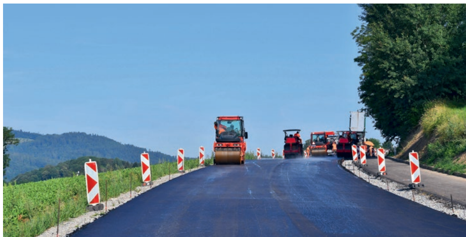
Einbau von Recyclingasphalt in Würenlos
