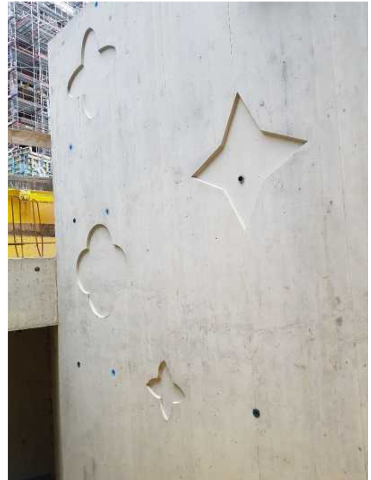
Sichtbetonwand KiTa
