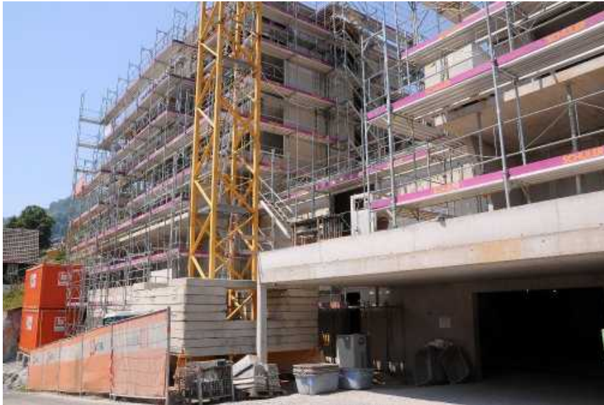
Mehrfamilienhäuser Ennetbürgen, 100% RC-Beton mit Susteno
