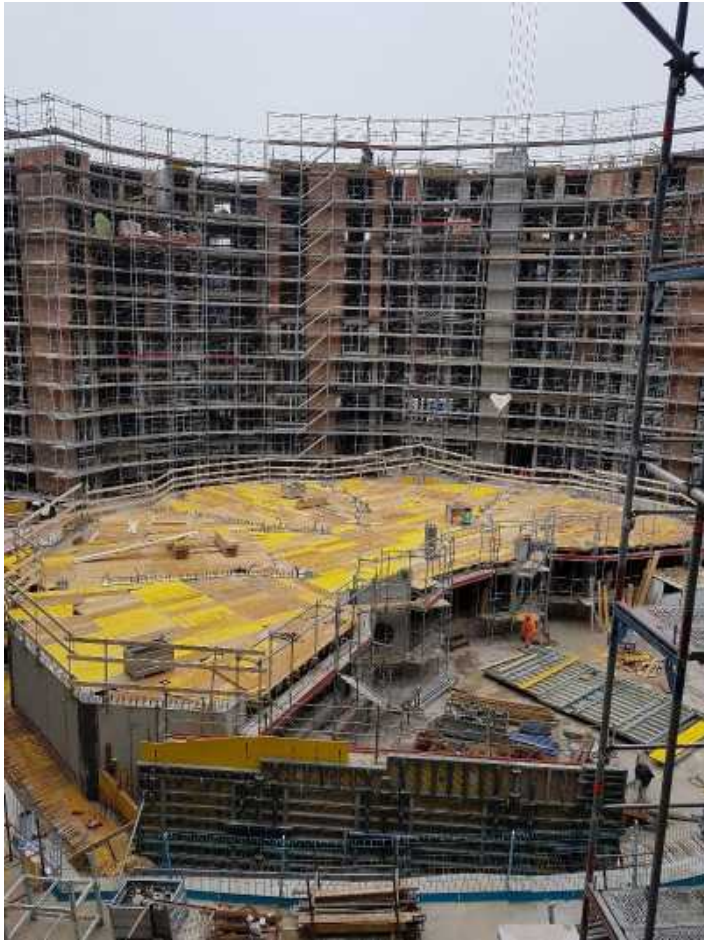
Wohnüberbauung Guggach II am Fusse des Käferbergs in Zürich
