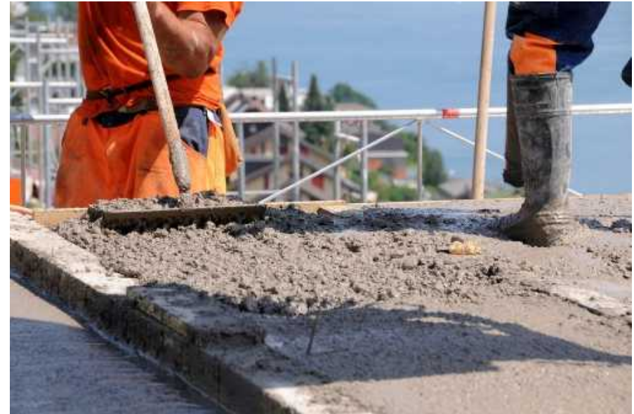
Einbau Deckenbeton
