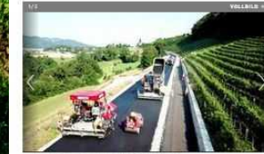
Neufahrer, Aargau. Das Kantonsamt in Rotholz lässt sich Zeit bei der Verlegung.
