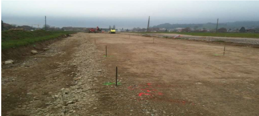
Quelle: Bau-, Verkehrs- und Energiedirektion | Tiefbauamt des Kantons Bern Leistungen B+S: Projektierung bis Phase 33 / externe GPL Phasen 41 - 53
