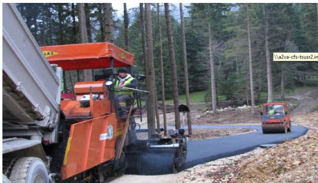
Quelle: Bau-, Verkehrs- und Energiedirektion | Tiefbauamt des Kantons Bern Leistungen B+S: keine
